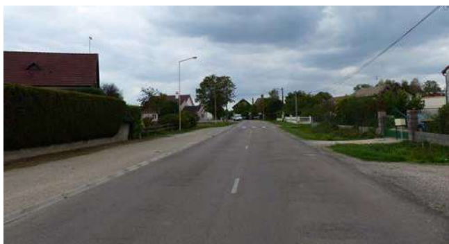
Le long de la RD20, quartier de Richebourg
