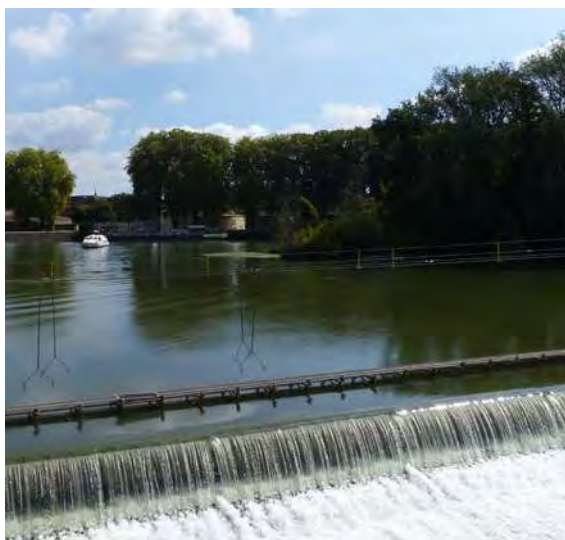
Le barrage mobile à aiguilles
