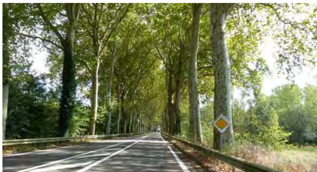
Commune de Villers les Pots, RD 905 et remarquable alignement de platanes
