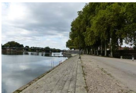
Le caractère très construit du quai situé au sud du pont
