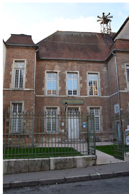
Photo repérage 1er trimestre 2019
