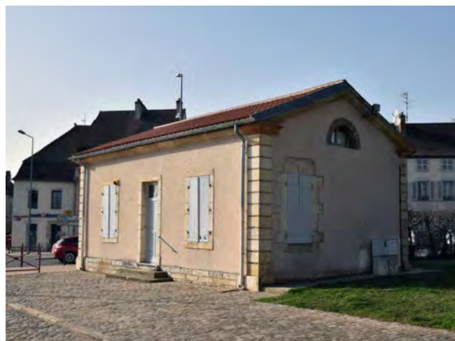
Photo repérage 1er trimestre 2021
