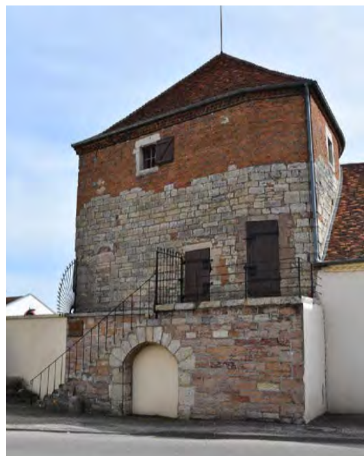
Photo repérage 1er trimestre 2019
